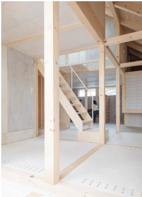
リビング・ダイニング。床下にはパネルヒーターが設置されており、暖められた空気が穴を通して建物全体を循環する仕組み
