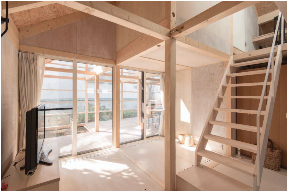
リビングからテラスを見る。4間角の室内南西側に2間幅のテラスが取り付く構成で、1間ピッチで105度の柱を立て、柱間を繋ぐ土台と梁を露出させグリッドを浮かび上げらせる。床、壁共にオスモ塗装の上、ヤスリがけ。1階の天井高は既製建具の寸法に合わせ、かつ建材を最大限有効に使うため2,050mmとしている。
