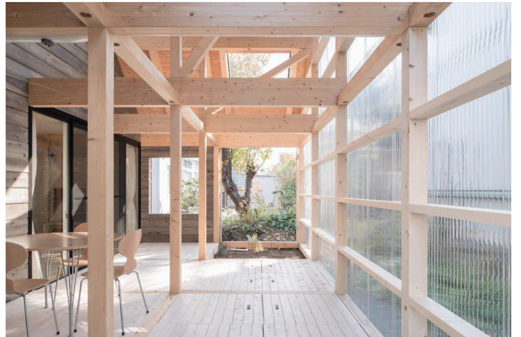
テラス。土台、柱、梁の構成は内外同様に連続させている。1間角のグリッドのうちひとつの床は土とし、この空間が半外部であることを意識させている。
