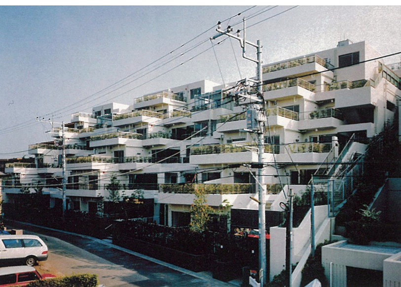
H2システムのプロトタイプによるユニテ宮崎(左/2000年竣工)。斜面地住宅は立体的な雁行ととらえ、斜行を生かし基礎を斜めにし、地耐力ではなく地盤との摩擦によって持たせるという考え方で、従来の階段状の基礎よりも土木工事の低減・コストダウンを実現した環境を壊さない独特の工法。広いルーフトラスが魅力で、戸建感覚で各戸に優れた採光性と眺望をもたらすプランとなっている
