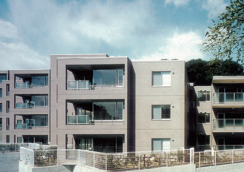
T2システムのプロトタイプによるパースシティ 柿生(左/1997年竣工)。雁行型(上)とすることで端の住戸だけでなく中間に位置する住戸も全て3面開口を可能にした。バルコニーを室内側に引き込んだ半屋外空間的なインナーバルコニーとL型コーナーウィンドウによって従来の分譲マンションにはない大きな開口を実現。また、表面積が大きいことでコストアップになりそうな点については、予算配分がシビアなホテル設計の経験を生かしてクリア。主に札幌と川崎で展開した
