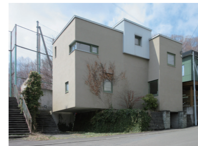
西野の浮かぶ家(1999年竣工)。敷地の高低差を利用し、かつ以前に存在した住宅の痕跡(時間の痕跡を残す)の上に浮かぶように建つ。コンパクトで機能性を高い空間、人間本来の時間を取り戻せるような空間や住むことの意味を考えて設計
