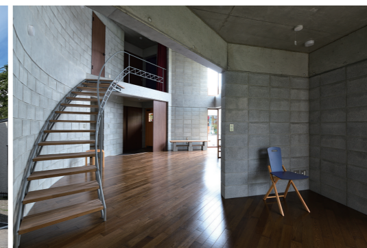
内部に曲面を持つ家(左2点/2019年竣工/撮影:KEN五島)。徐々にブロック二重積み外断熱住宅が実現。2層分吹き抜け空間をブロックの曲面が柔らかく包み込む。道産ブロックは軽量で爽やかな印象を与えるのも特徴。「あの清涼感、爽やかさをもうちょっと表現できたらいいな」と言う。なお、この住宅も竣工時から数回に渡って温度データを採取中
