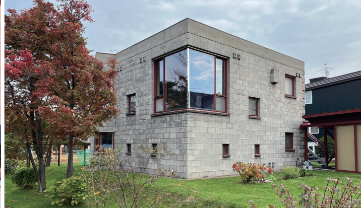
軸のずれた家(上3点/1985年竣工/2013年度 第13回JIA25年賞)。住まい手の室温計測によって、築後25年のブロック二重積み外断熱住宅が冬の無暖房期間(12月初めから1月初めの不在時)に室温5℃を切らなかったことが判明(左のグラフ)し、外断熱の良さおよびブロックの熱容量が示された。温まった壁や床が冷めにくい「粘る家」であり、災害時の活用にも期待できる。真ん中の写真は、熱容量の効果の指標化に向けた若手の建築家・研究者および住まい手との意見交換の様子
