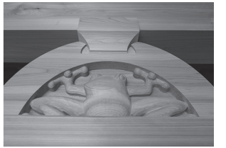
恵弘寺(上・右/2023年竣工、畠中秀幸さんとの共同設計/撮影:前澤良彰)。1階を参道、2階を本堂に。伝統工法と現代工法の融合であるが、伝統工法だけでも成立する形式とのこと。蛙股の装飾は蝦夷赤蛙(写真右)、蝦夷雪うさぎ、蝦夷モモンガがある
