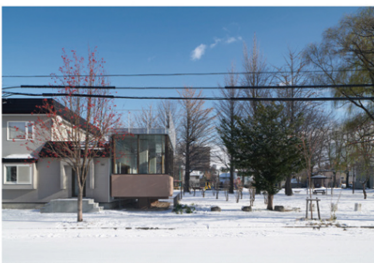
道路より見る。既存2×4住宅の公園側に開放的なキッチン棟を増築。
