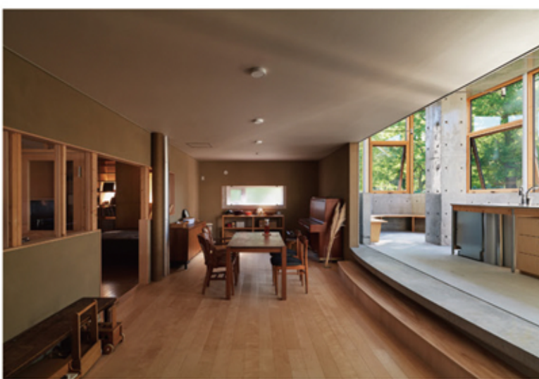
大きく異なる空間と接続する。開放的な空間性によって、既存2×4住宅の限定的で狭い面積が、落ち着いた快適な「面」へ変わった。ダイニングの床は8パズルタイル。壁は石灰。両面効果を実現して土壁とした。
